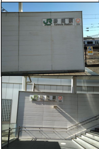
撮影ポイント CP1 勝田駅西口・東口
